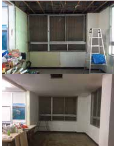
(上) 布天井施工前 (下) 布天井完成
