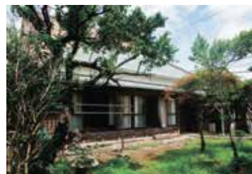
(写真) お試し移住体験施設
