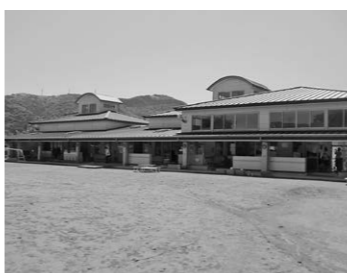
風雨対策が急がれる「ひがしいず幼稚園」園舎
