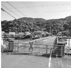
通行止め中の白田川橋
