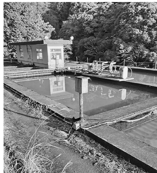
建設から50年が経過した白田浄水場
