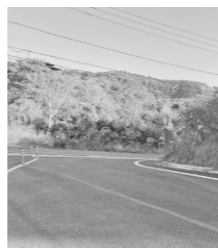
伊東市境界近くまで整備中の湯ヶ岡赤川線
