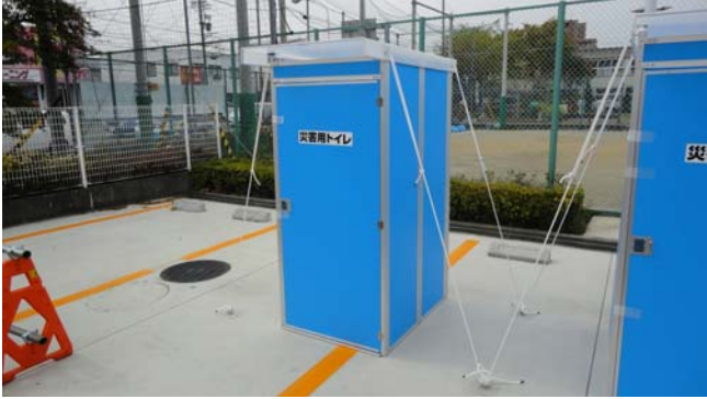
学校施設の防災機能強化のため、トイレ機能喪失への緊急的な対応として、 地震災害時用下水道接続型仮設トイレ（マンホールトイレ）の整備 （県立静岡農業高校）
