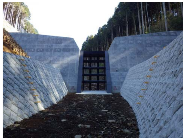
土砂災害の軽減を図るために設置した砂防堰堤 さほうえんてい (「深良川右支川」裾野市深良地先)
