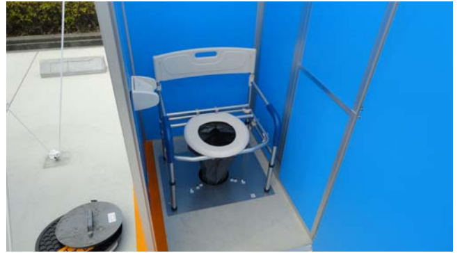
学校施設の防災機能強化のため、トイレ機能喪失への緊急的な対応として、 地震災害時用下水道接続型仮設トイレ（マンホールトイレ）の整備 （県立静岡農業高校）
