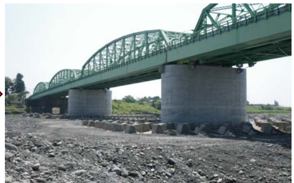
発災時における緊急輸送路としての機能を確保するための橋梁耐震対策 (富士由比線 富士川橋 富士市松岡)
