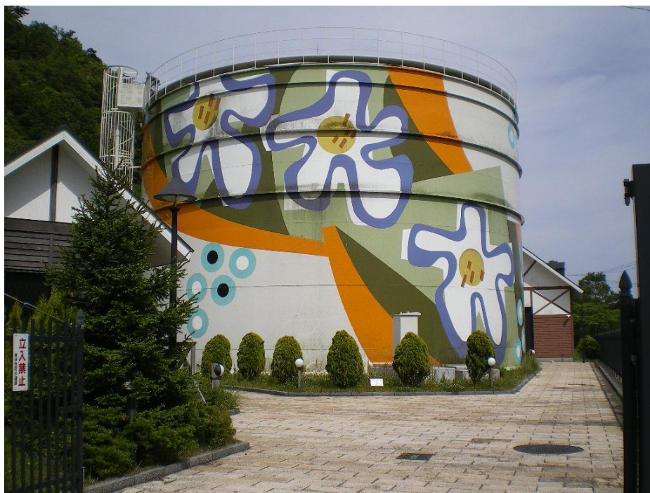
新稲取配水池
