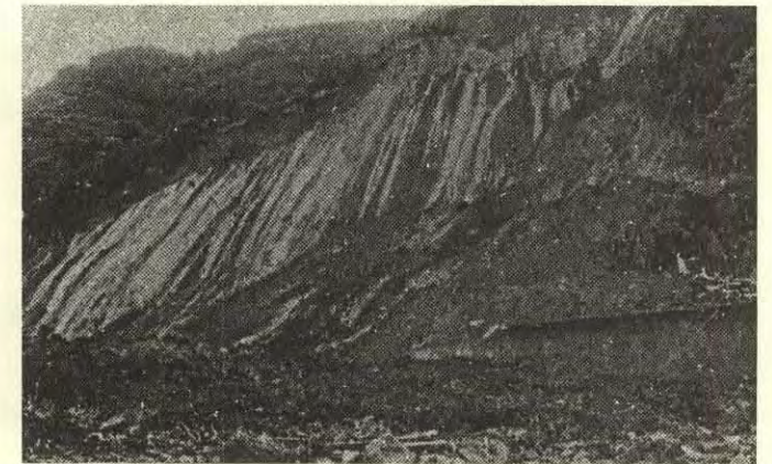
東伊豆町白田の有料道路決壊現場 道路も伊豆急線路も民家も ひと呑みにして海岸になだれ落ちた
