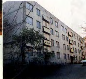
48年、稲取町営住宅完成
