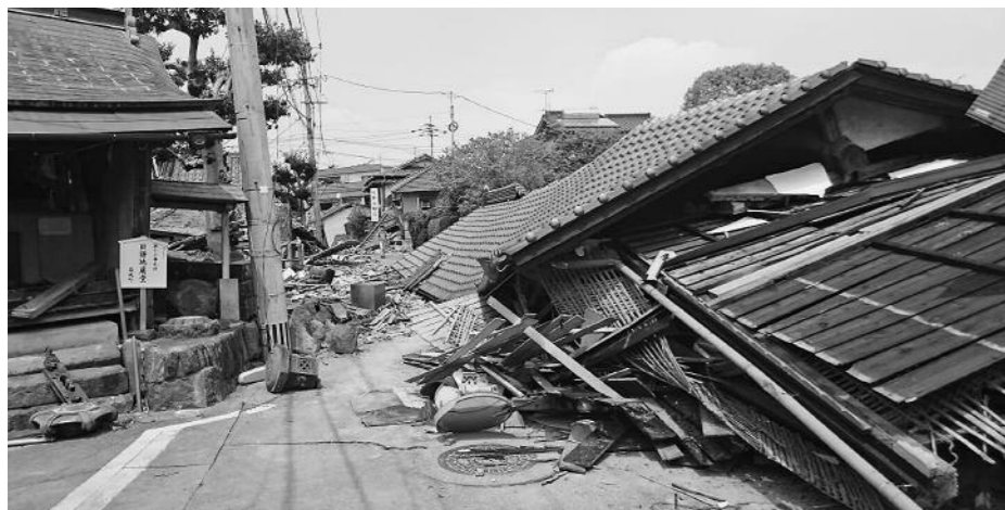
平成28年4月14日発生 熊本地震による益城町の被害状況（静岡県提供）
