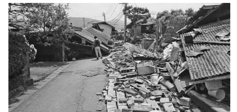
平成28年4月14日発生 熊本地震による益城町の被害状況【静岡県提供】
