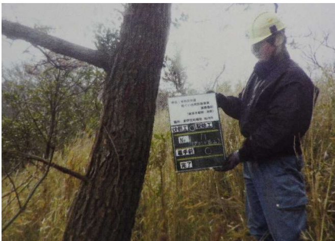
（作業前：伐採木確認）
