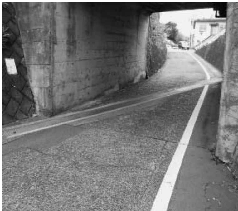
稲取小学校へ下る道路に斜めに横断して設置されているグレーチング
