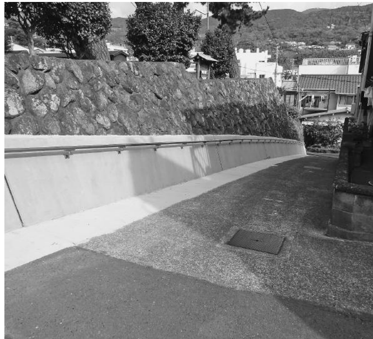
急な坂道に手すりがつきました
