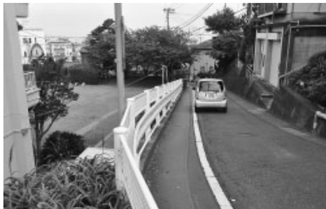
入谷から下る稲取小学校横の道路 路側帯とカラー舗装で歩行者の安全を確保
