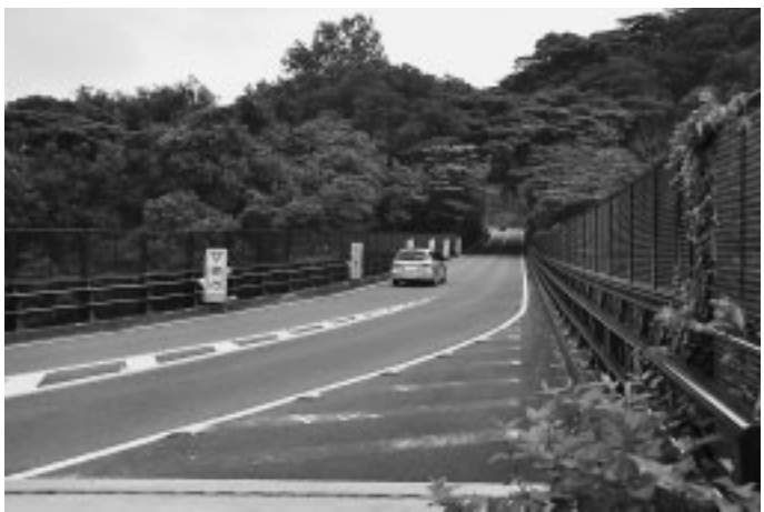
国道135号線の熱川大橋 車道は確保されているが歩道は無い
