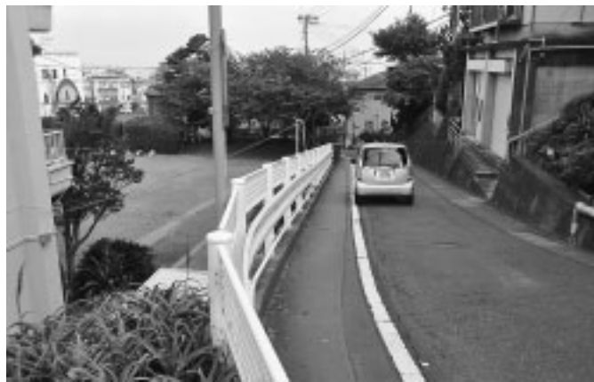
入谷から下る稲取小学校横の道路 路側帯とカラー舗装で歩行者の安全を確保
