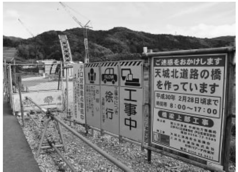
建設中の伊豆縦貫道(天城北道路)天城湯ヶ島インターチェンジ付近
