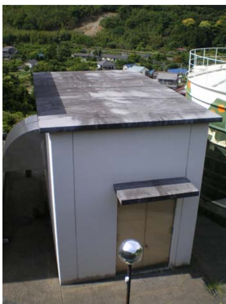
図5 稲取第一中継ポンプ場の自家発電室
